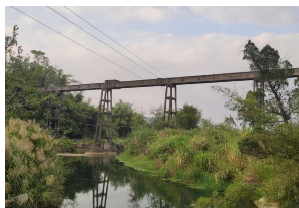
(b) 田庄渡槽
