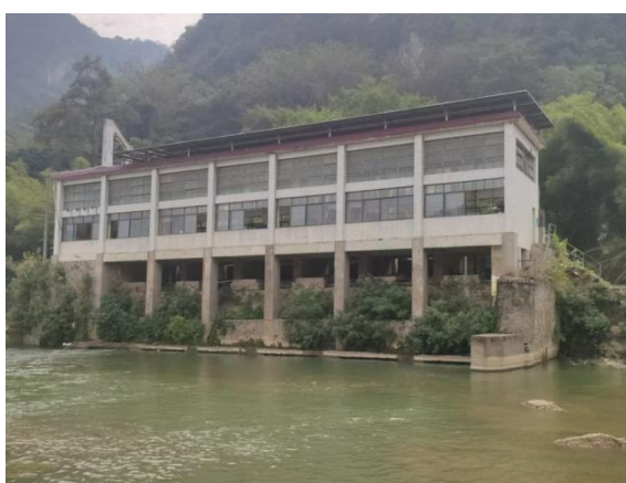
(h) 大东坪水电站
