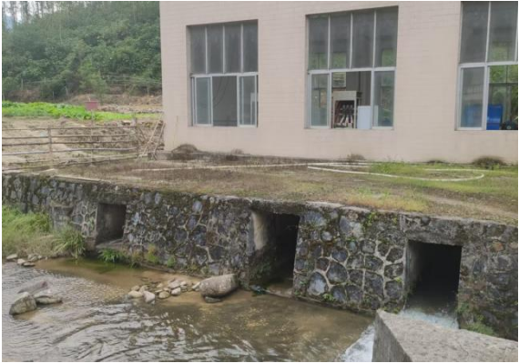
(b) 大洞水电站
