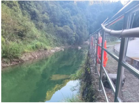
(a) 龙珠峡电站
